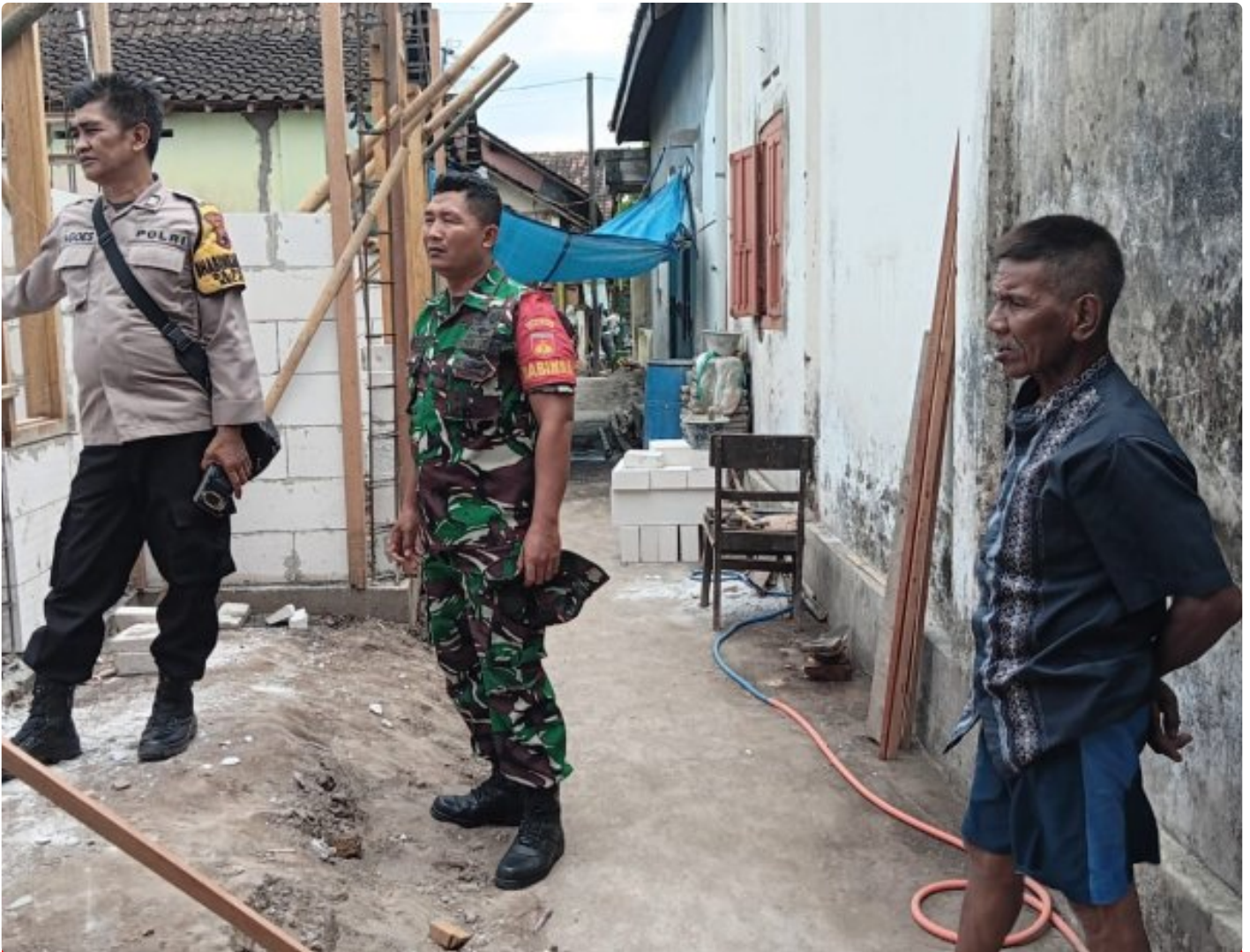
Pembangunan RTLH Desa Binaan, Ini Kata Babinsa Ceper
