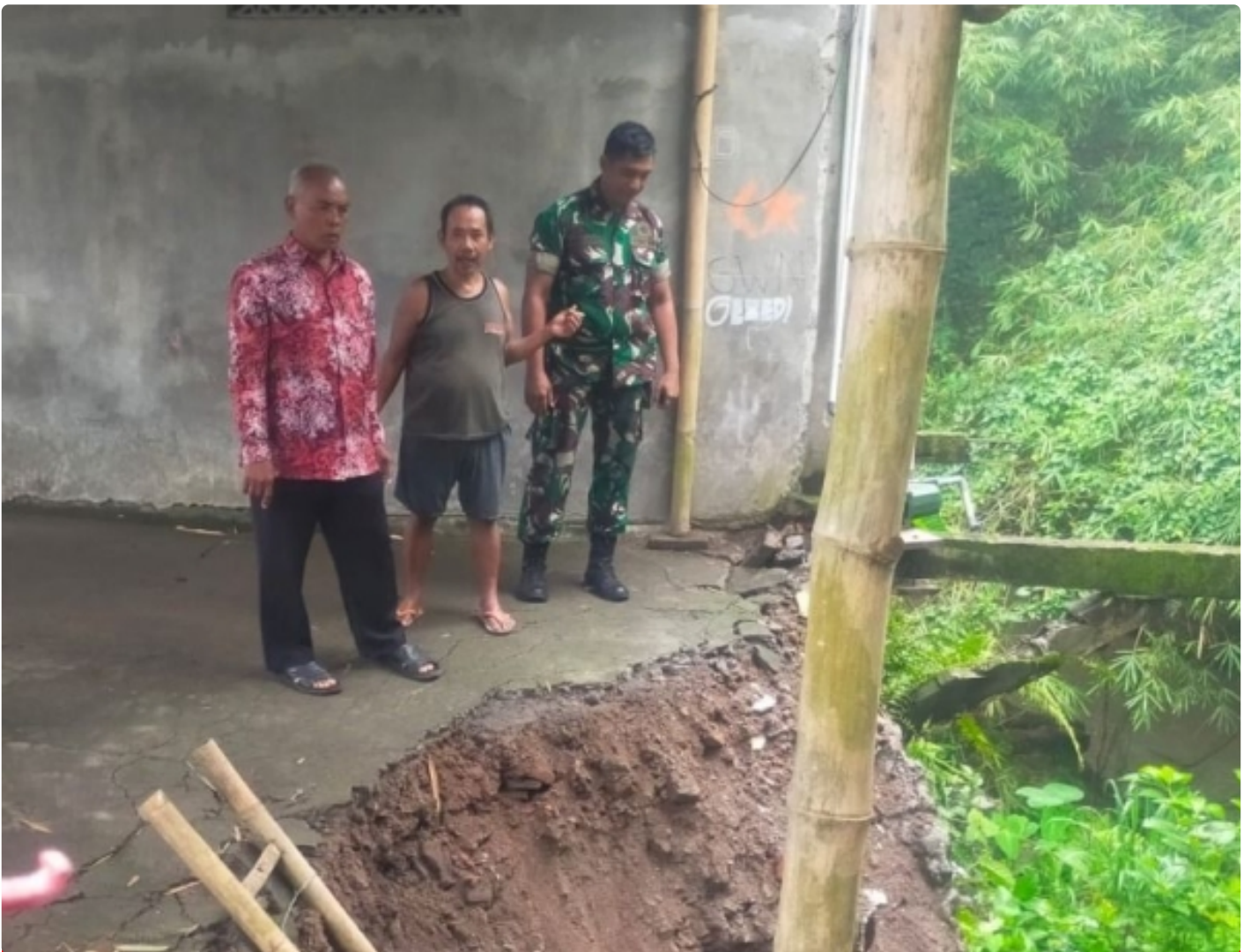
Longsor Di Desa Jambukulon Danramil 23/Ceper Bersama Muspika Tinjau Lokasi Longsor
