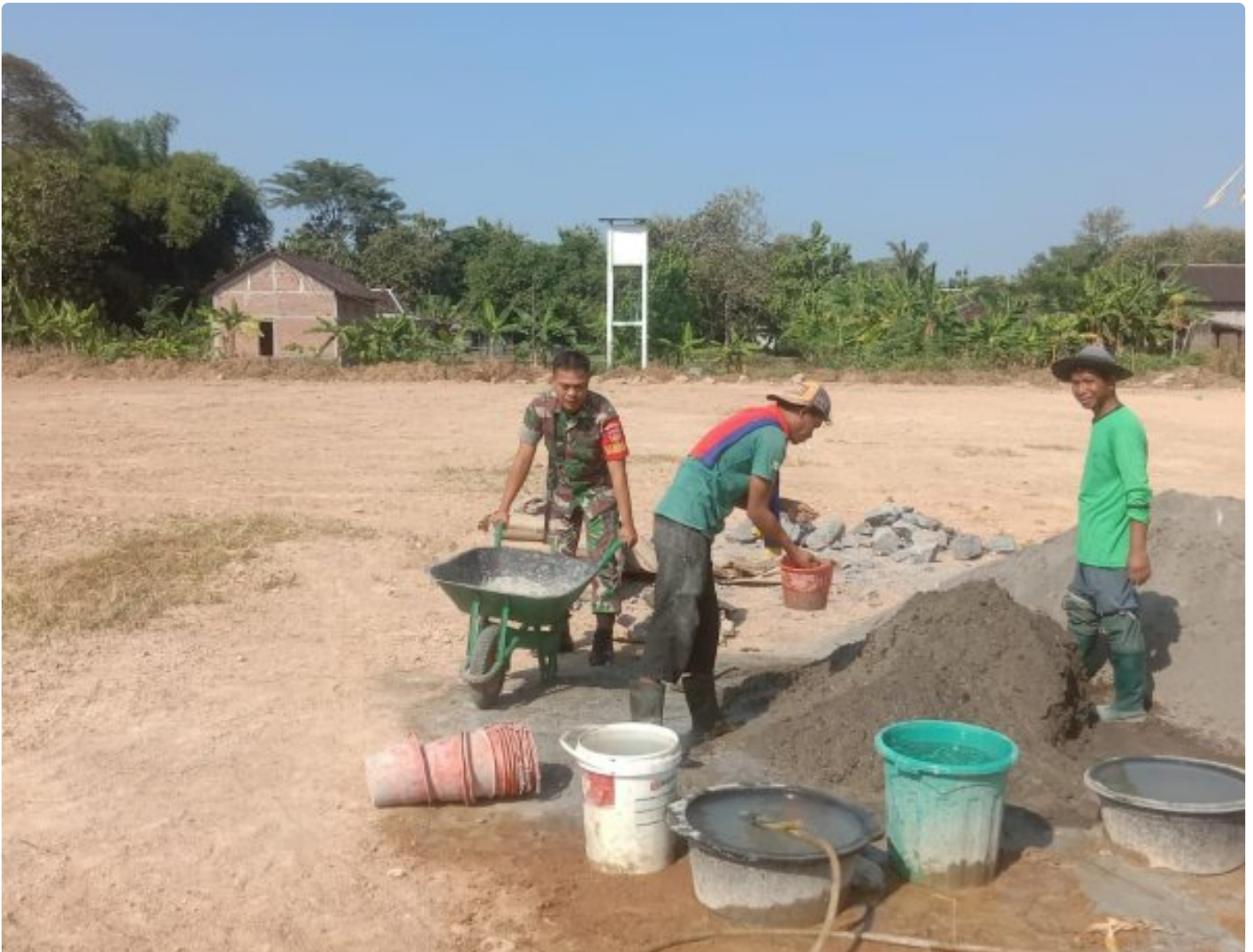
Koptu Suyono Dampingi Pembuatan Talud Lapangan Bola Desa Sidowarno, Ini Katanya
