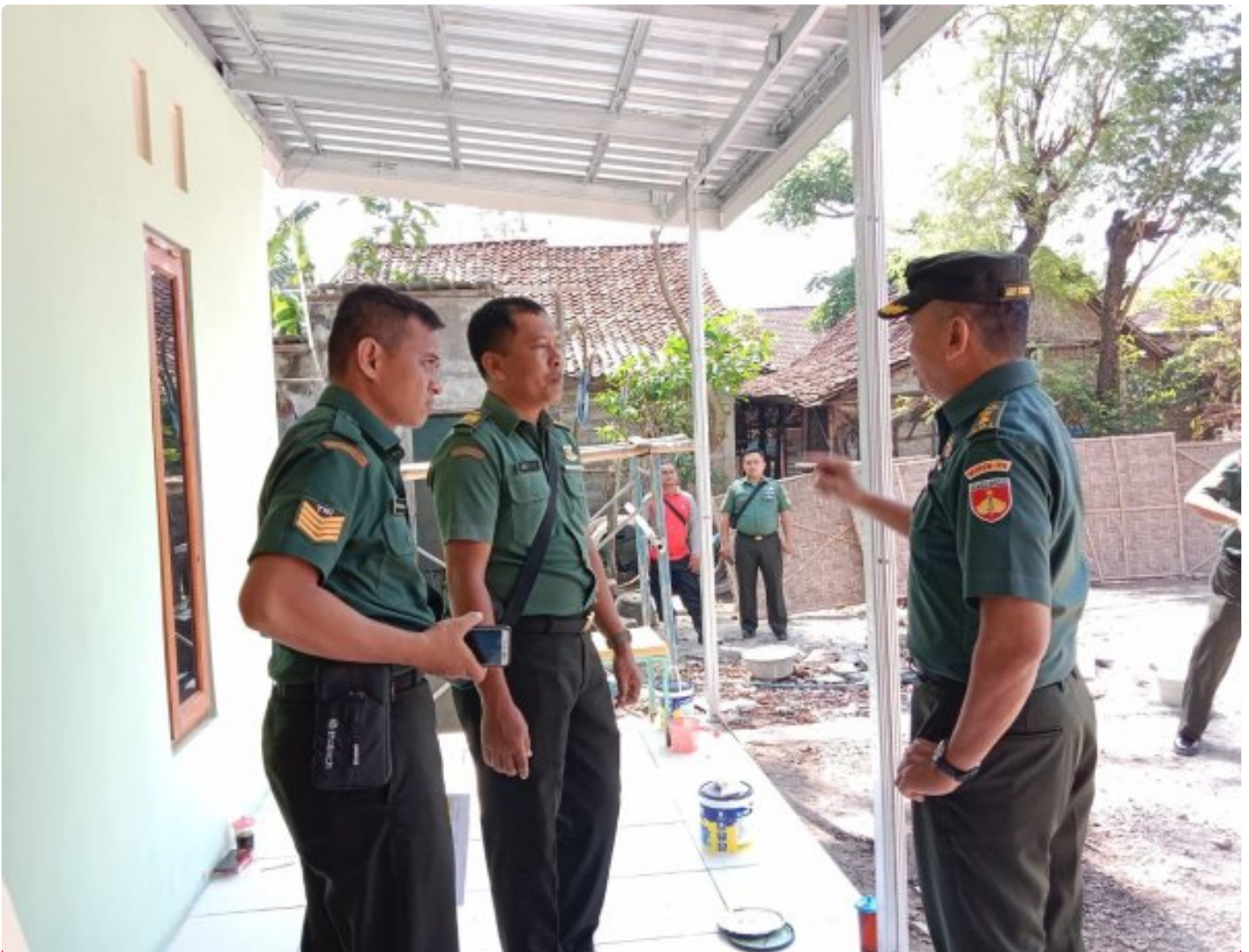
Kasiter Korem 074/Warastratama Kunjungi Pembangunan RTLH Di Wilayah Kodim 0723/Klaten
