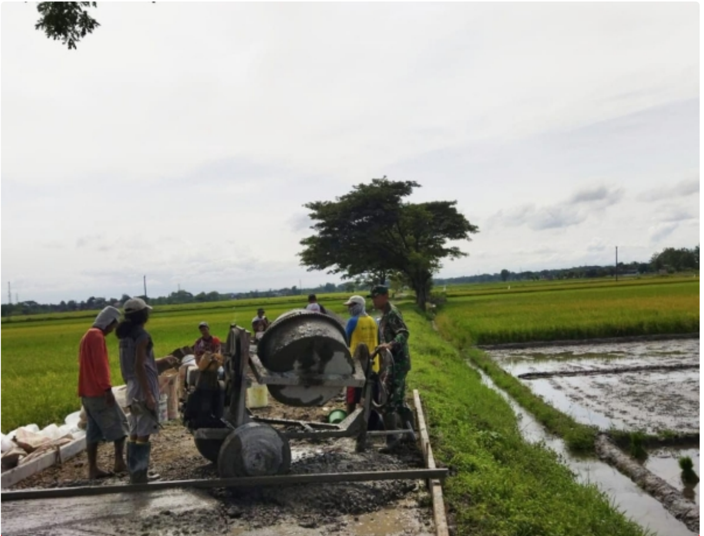
Gotong Royongnya Babinsa Juwiring Bantu Betonisasi Jalan
