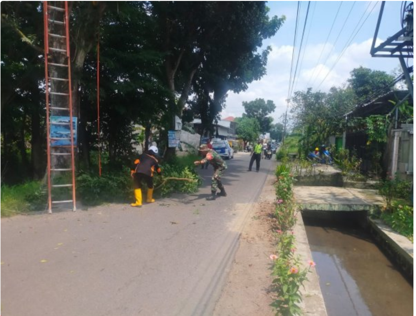
Cegah Pohon Tumbang, Pohon Jalan Poros Delanggu – Juwiring Dibersihkan
