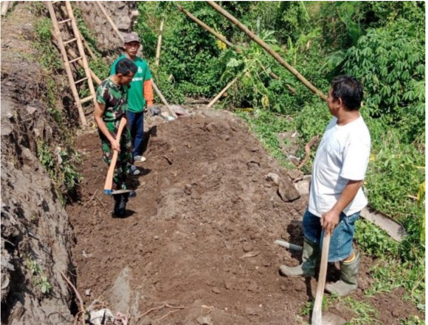
Babinsa Koramil Ceper Bersama Warga Karya Bangun Talud Jalan
