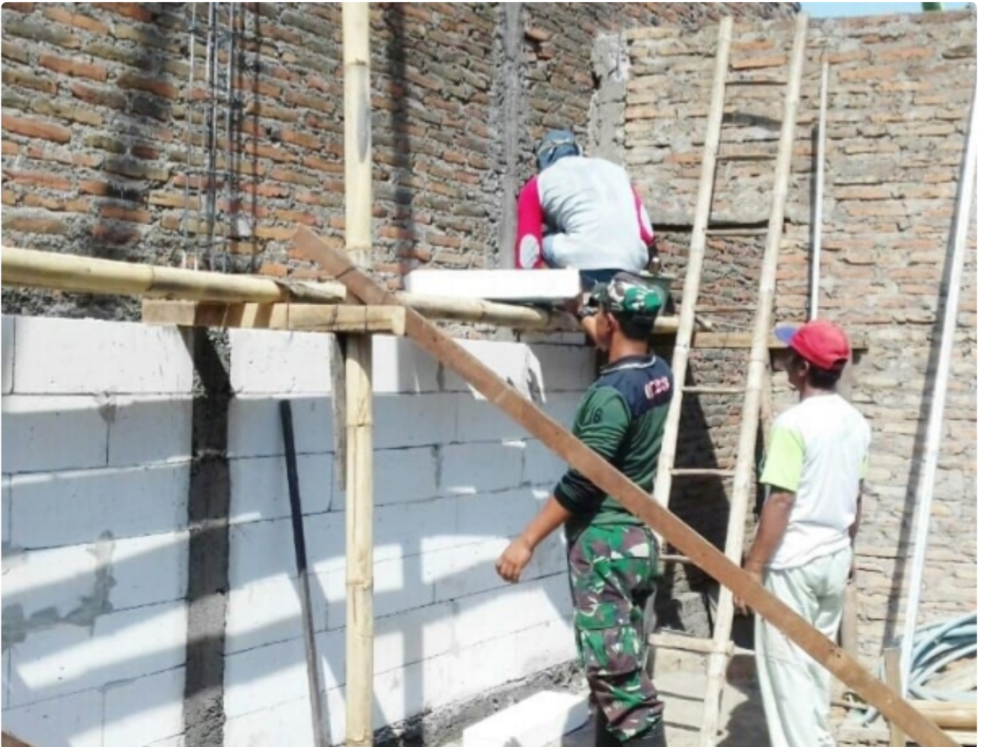
Babinsa Ceper Gotong Royong Bangun Rumah Warga Binaan
